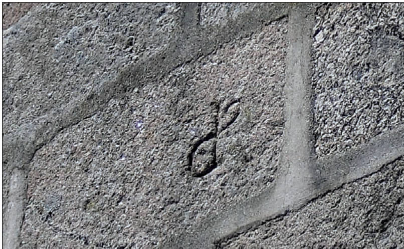
Marca de canteiro na cabeceira
