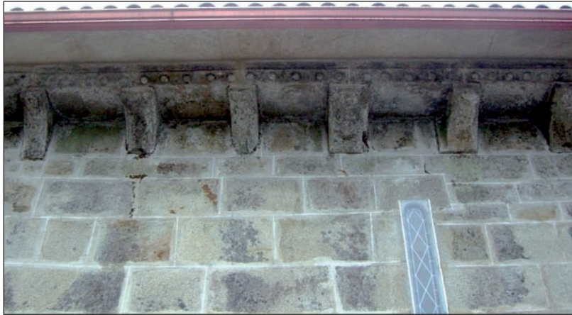
Cornixa pomada no muro sur da ábsida
