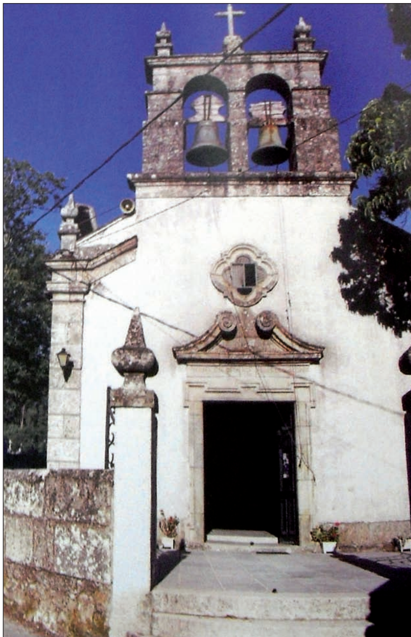
Fachada da igrexa antes da restauración de 2005-06
